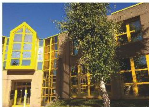
Antenne de Bagneux
